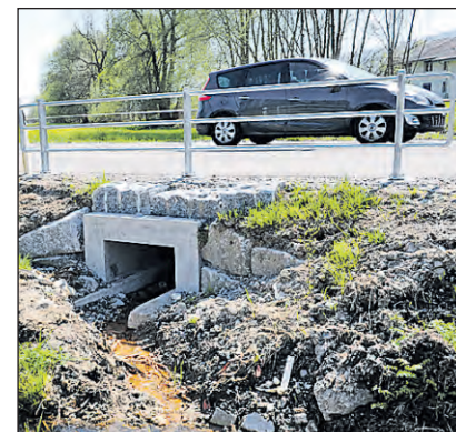
Durchlass für Kleintiere: Dieser Tunnel unter der Hauptstrasse Mosen-Aesch ist wichtig für die Vernetzung der Gewässer.
